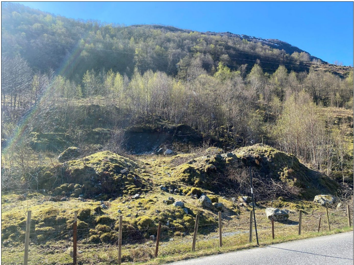
Figur 11: Løsmasser i skråning sør for Stongfjordvegen, sør for tiltaksområde 1. Løsmassene i området er moreneavsetninger og elveavsetninger.
