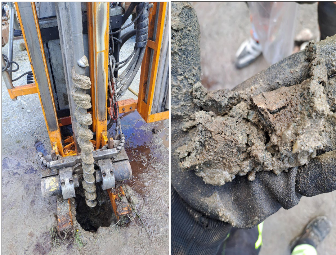
Figur 4: Løsmasser langs borestang i borpunkt 1. Løsmasser viser av sand med steiner, noe som ikke stemmer overens med totalsonderingen borpunktet 1.
