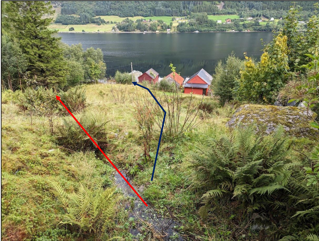
Figur 26: Sidebekken til Fremstelva. Her er det laga ei grøft som leiar den inn i hovudelva (raud pil). Ved flaumhendingar kan vatnet renne rett fram i det opphavelge løpet og før det renn inn i Fremstelva rett før utløpet i fjorden (blå pil). Dei fire nausta ligg til høgre for bygningane som ein kan sjå på biletet.
