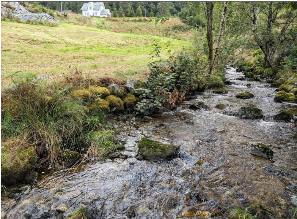
Figur 23: Bilete teke mot aust med gbnr. 13/54 til venstre. Det er ei eldre forbygging med runda blokker noko tilbaketrekt frå elveløpet. Det er ikkje teikn til vesentleg erosjon eller utglidingar langs elveløpet.
